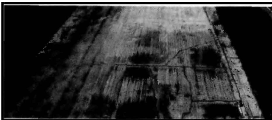
1.8 –сурет - Бетонды төсеніштердегі сызаттар
